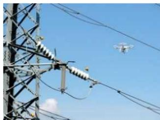
近年, ドローンを用いた送電線などの, 電力設備の点検が行われている。AIを用いて撮影した画像の判別を行うことで, 点検作業の効率化が期待される。
